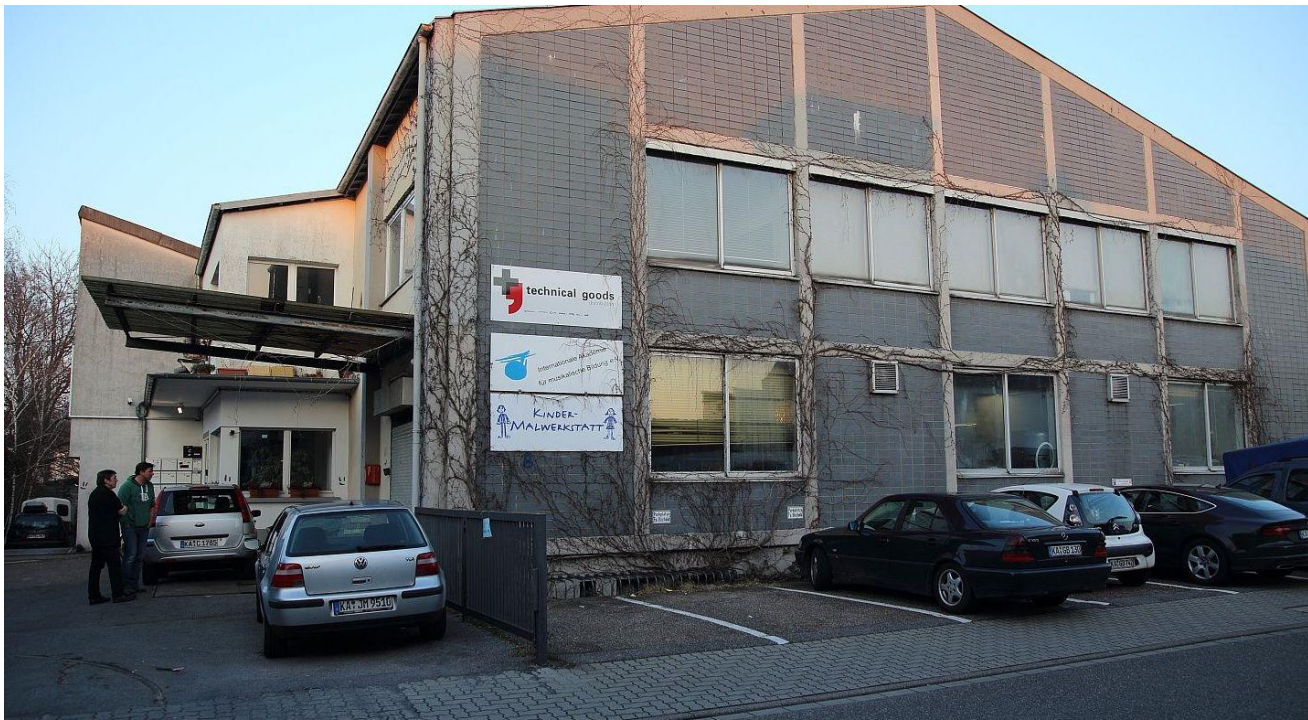
Außenansicht des Gebäudes in der Gablonzer Straße 8, Foto: Reiner Buck
